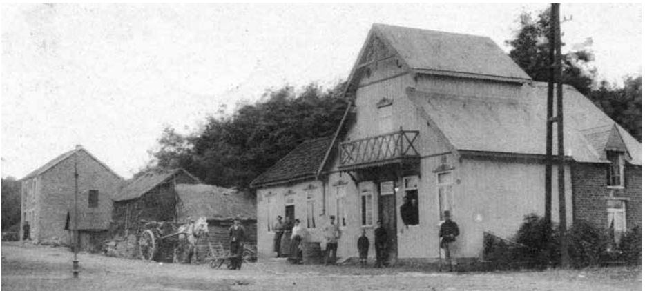
« Le chalet » de la gare vers 1900.
