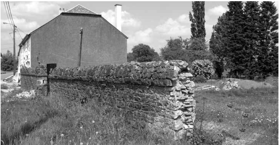
Couvre mur en blocs de laitier de haut-fourneau
