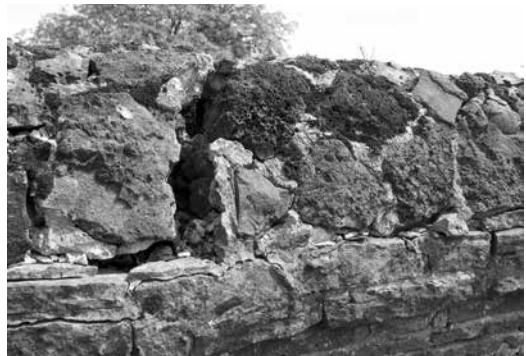
Couvre mur en blocs de laitier de haut-fourneau
