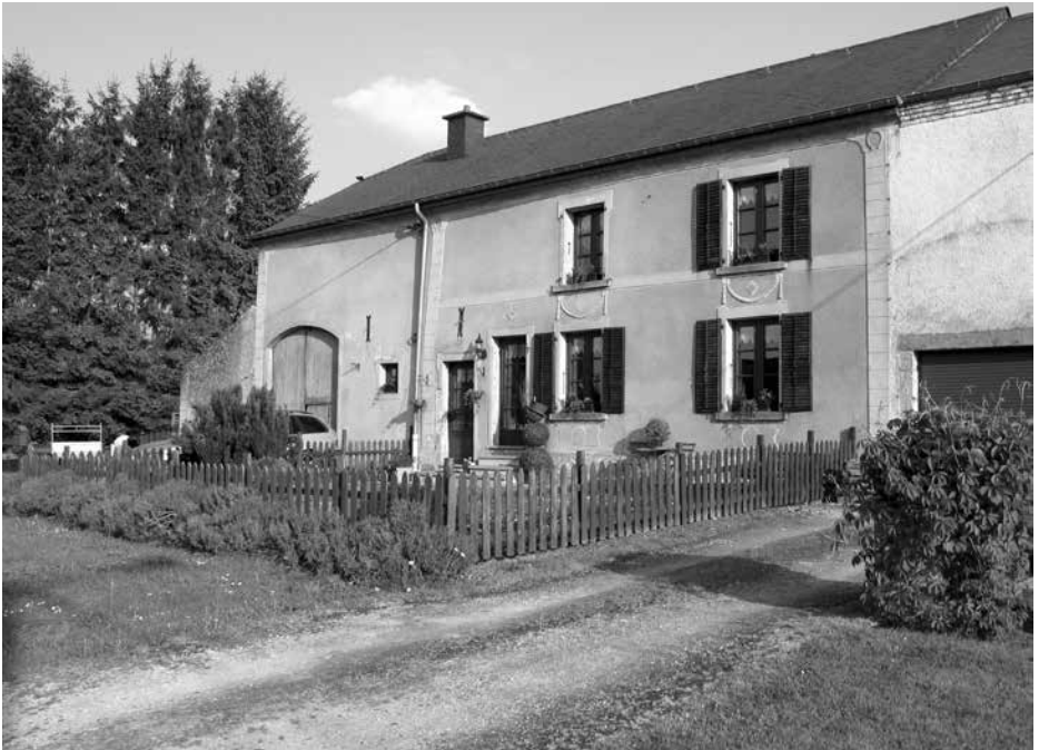
Maison située au plus bas du village, rue du Monument, n° 7
